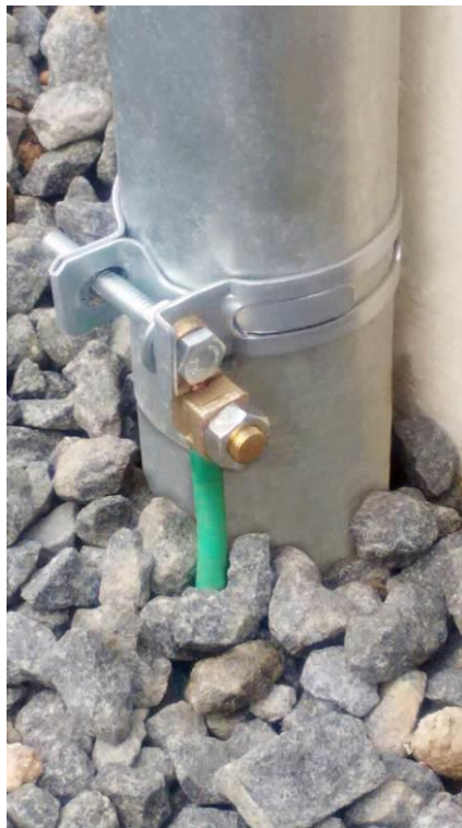
Foto ilustrativa 02 dos anexos W, Y, AA, BB, CC, DD e EE – Detalhe da abraçadeira de com terminal para aterramento
