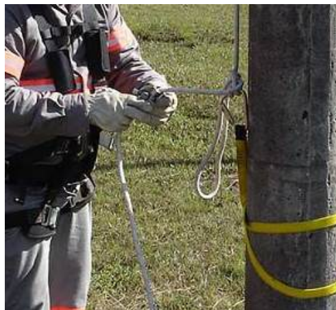
Figura 39 – Instalação do trava-quedas
