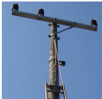
Figura 17 – Ancoragem na ferragem do poste
