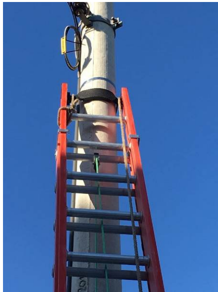
Figura 23 – Posicionamento da escada
