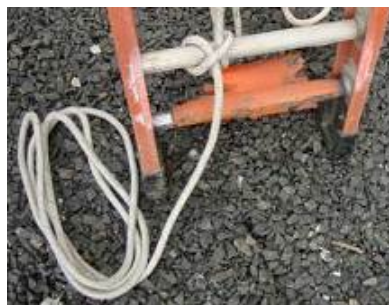
Figura 18 – Nó fiel na base da escada
