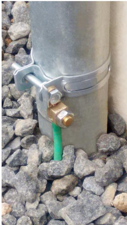
Foto ilustrativa 02 dos anexos G, H e Q – Detalhe da abraçadeira de com terminal para aterramento
